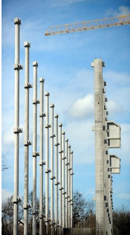
6. ábra. a: Homlokzati és belső pillérek b: Előre gyártott feszített körpillérek
