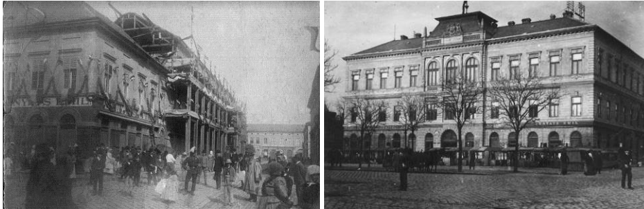
A Tisza-palota emeletráépítés alatt és készen
