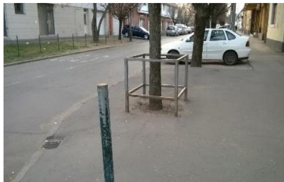
9. ábra. Egy debreceni utcarészlet: fák víz és talaj nélkül – a lefolyó csapadékvíz gyorsan elvezetésre kerül a túlterhelt csatornába
