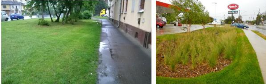
10. ábra egy debreceni utcarészlet: Bal oldalon széles zöld sávon tud elszikkadni a csapadékvíz; javaslat: tovább javítható a megoldás, ha egy megfelelően méretezett mélyedésben biztosítjuk a beszivárgást, ahogy az a jobb oldali képen látható [ http://thinkgwi.com/wp-content/uploads/2012/08/DSCN4268.jpg ]
