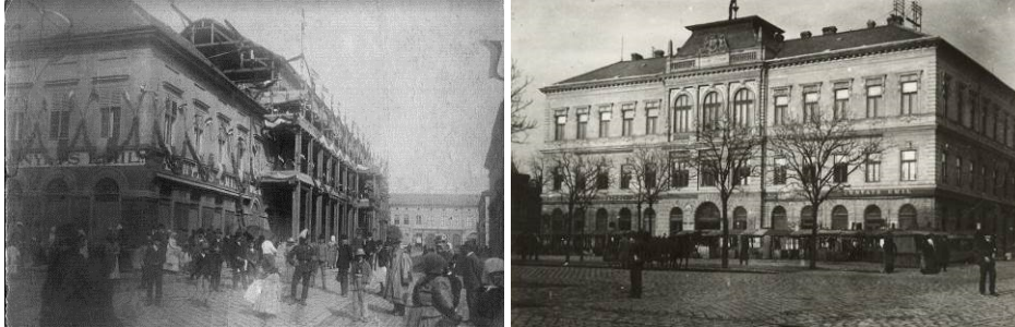
A Tisza-palota emeletráépítés alatt és készen
